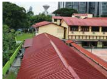
更换屋顶完成后图片
